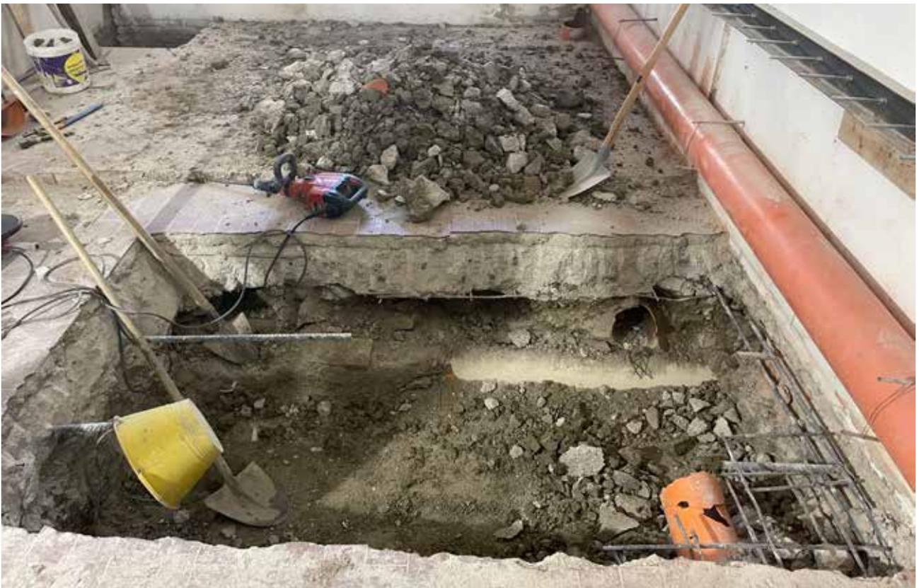
fra due edifici preesistenti. I lavori consistono in un intervento già iniziato di consolidamento delle fondazioni e proseguiranno con il ripristino delle lesioni nei singoli alloggi; la durata indicativa degli interventi è di circa 5 mesi e dovrebbero ultimarsi per la fine del 2024.
