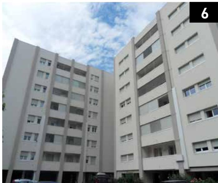
**7.** 2008 – STABILE "S1", VIA TIARINI, DI VINCENZO, ZAMPIERI, SERRA: *Intervento per la sostituzione degli infissi e sostituzione delle caldaie con caldaie a condensazione; nonché installazione del sistema di raffrescamento estivo.*
