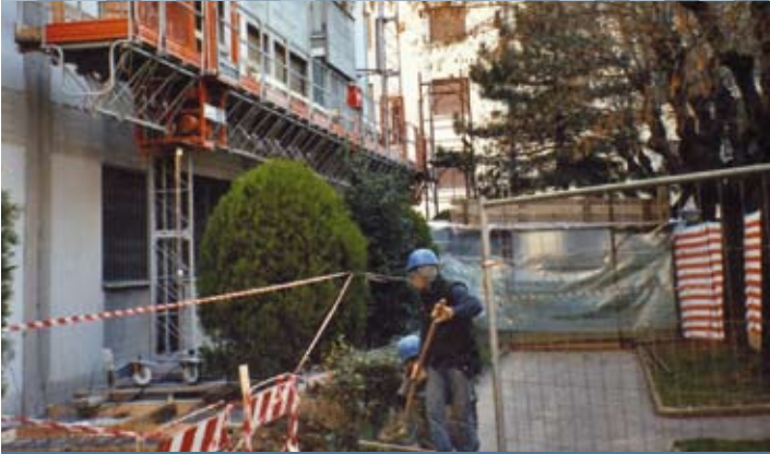
Cantiere via Napoli - 2006
